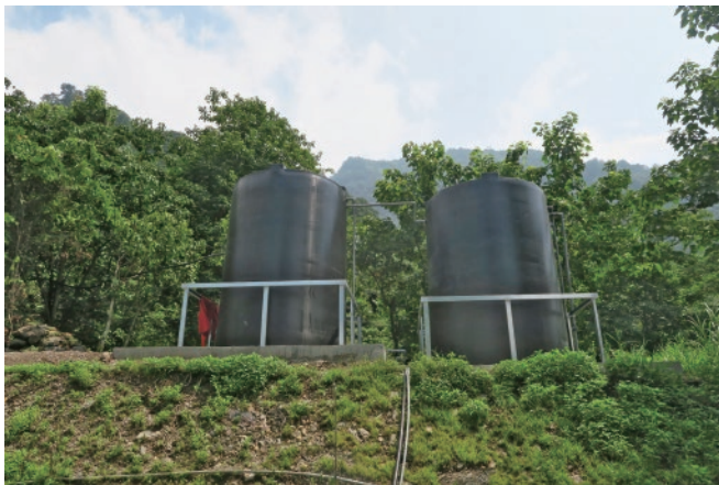
完成した山のわき水をためる 30 トンタンク 2 基
